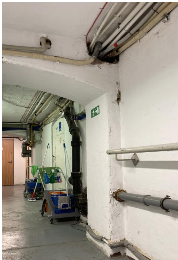
Widok stanu istniejącego – instalacje sanitarne do umieszczenia w kanale technicznym i za ścianką ażurową.
