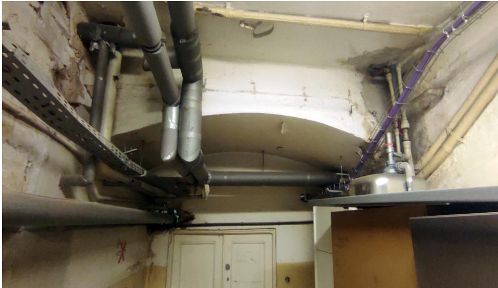
Widok stanu istniejącego – instalacje sanitarne do umieszczenia w kanale technicznym.
